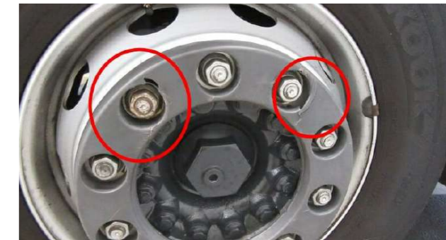
Poklopci točkova: Deformirani, puknuti, nedostaje materijal ili uklonjeni
