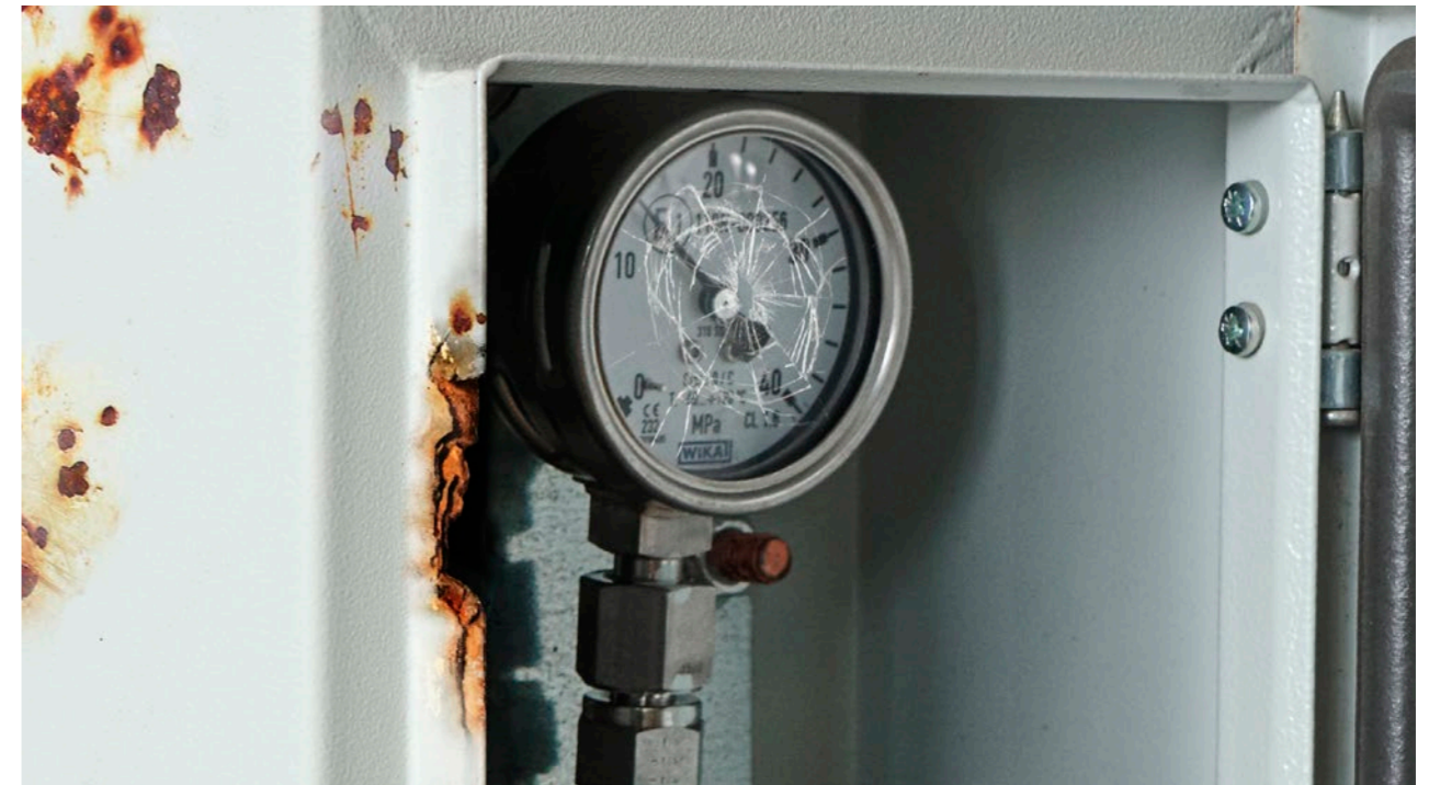
Nedostaje ključ zaštitne kutije, oštećen priključak za CNG ili manometar → naknada za zamjenu cijele kutije.
