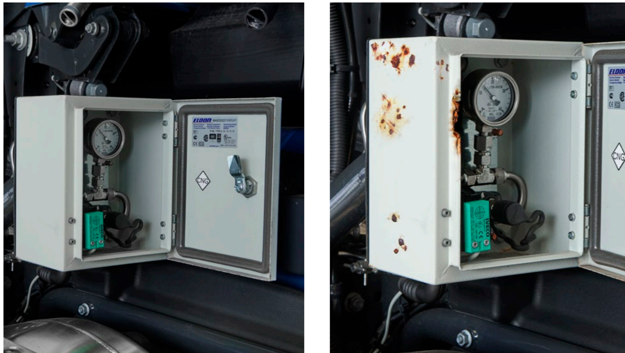
Hrđa na zaštitnoj kutiji priključka za punjenje → bilježenje bez naknade za oštećenje.
